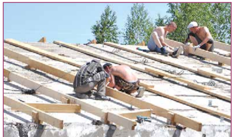
Важный этап работ - утепление кровли.
