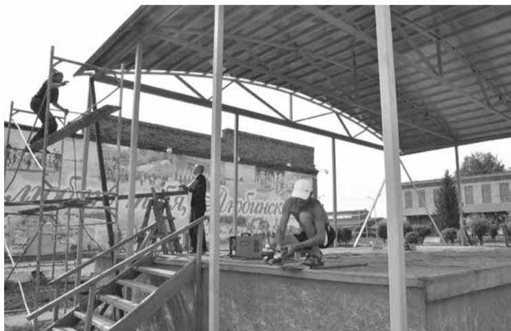
На площади Единения ведутся работы по установке крытой сцены, оформлению новой районной Доски Почёта, благоустройству территории.
